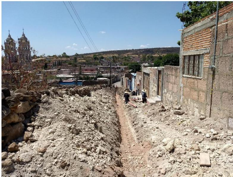
**Obra:** "Construcción de red de alcantarillado en la calle Hidalgo ubicada en la Delegación de Temastlán en el Municipio de Totatiche, Jalisco".
