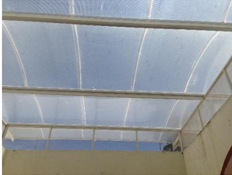
**Obra:** "Colocación de domo de policarbonato en el Centro de Salud de Totatiche, Jalisco".
